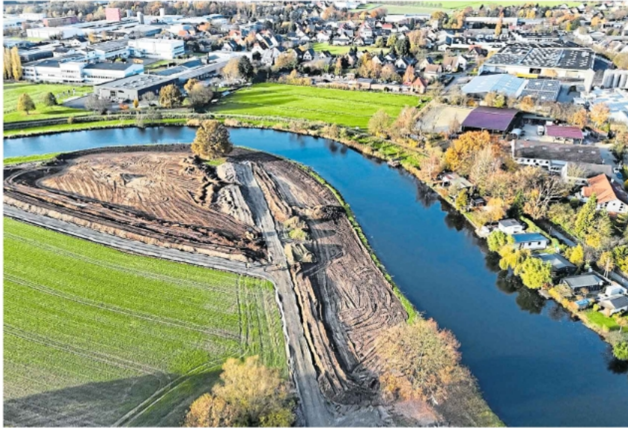
Auf einem Hektar Fläche wird derzeit der Oberboden in der Aue südlich des Werreknies abgeschoben.
